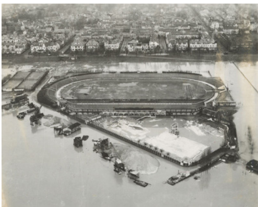
Flut am Weserstadion in Bremen 1994
