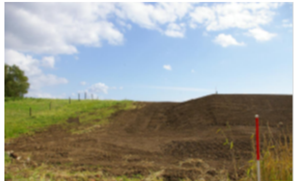
Deicherhöhung und -reparaturen in Bremen
